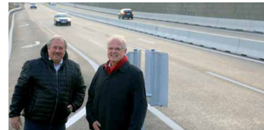
Verkehrstadtrat Alfred Scheichel und Bürgermeister Dr. Reinhard Resch bei der neu errichteten Mittel trennung mit Lärmschutzwand an der B37.
